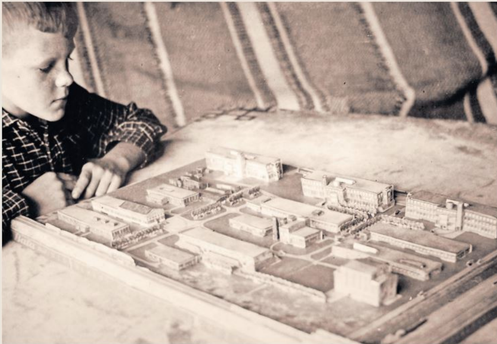
▲ Deze foto komt uit het familie-album van Evert Vinkenburg uit Westerhoven. Als kleine jongen buigt hij zich voldaan over een bouwplaat van het Bestse Bata-complex, dat toen veel groter was dan nu. De knutselwerken werden destijds door de schoenenfabrikant zelf uitgegeven. De foto is in 1941 gemaakt door vader Vinkenburg.
