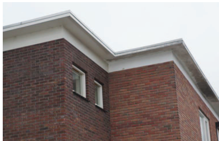
Voorbeeld van houten daklijst bij aanbouw die visueel één geheel vormt met oorspronkelijk dak overstek.
