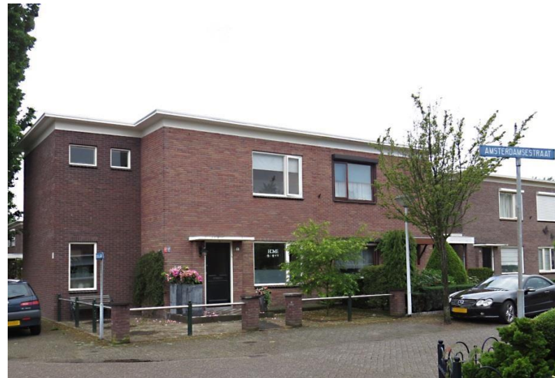
Voorbeeld van een authentieke kubusvormige massa en een aanbouw in een historiserende uitvoering.
