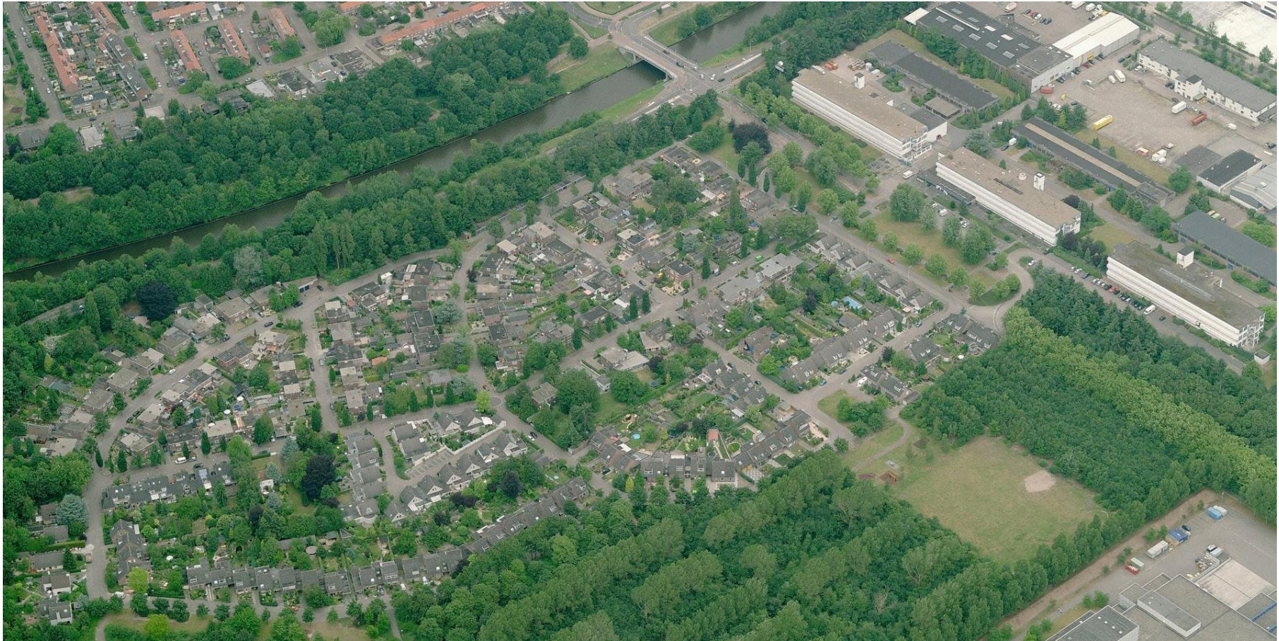
Luchtfoto van Batadorp gezien vanuit het zuidwesten. Rechtsboven de fabriek anno 2014. Links in het midden de woningen. Bron: www.bing.com/maps
